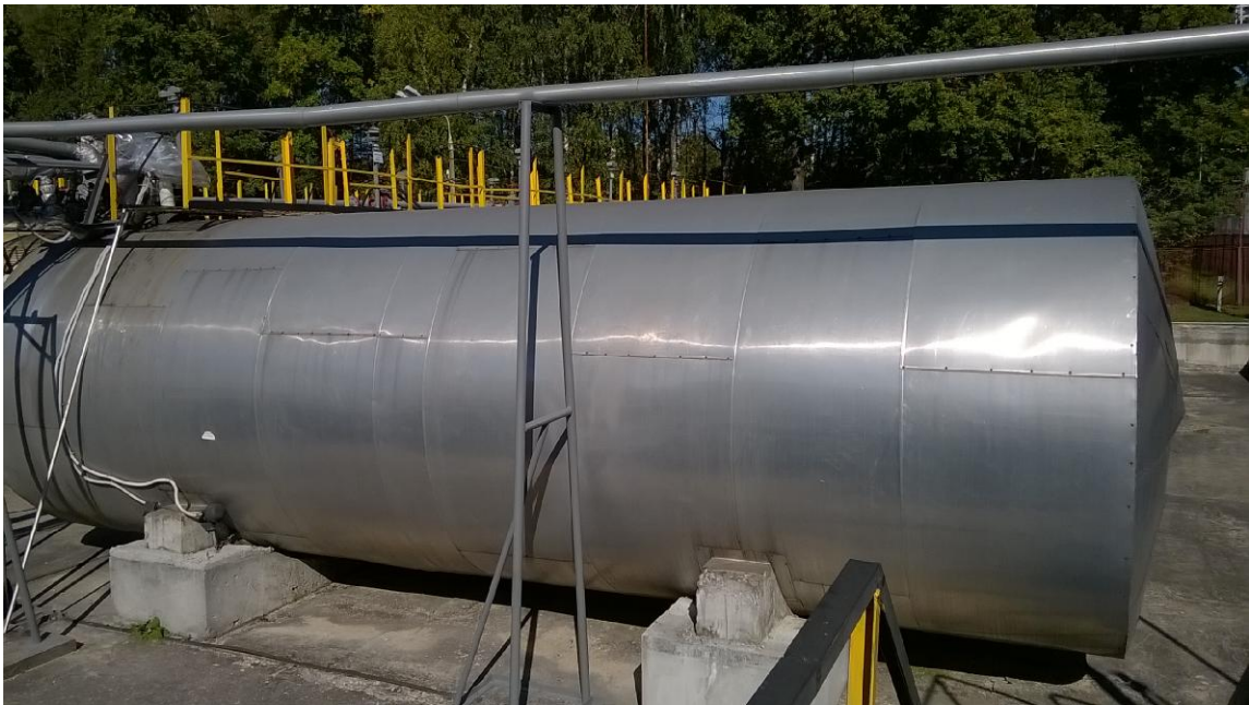
Рисунок 1 - Общий вид резервуара стального горизонтального цилиндрического РГС-50
