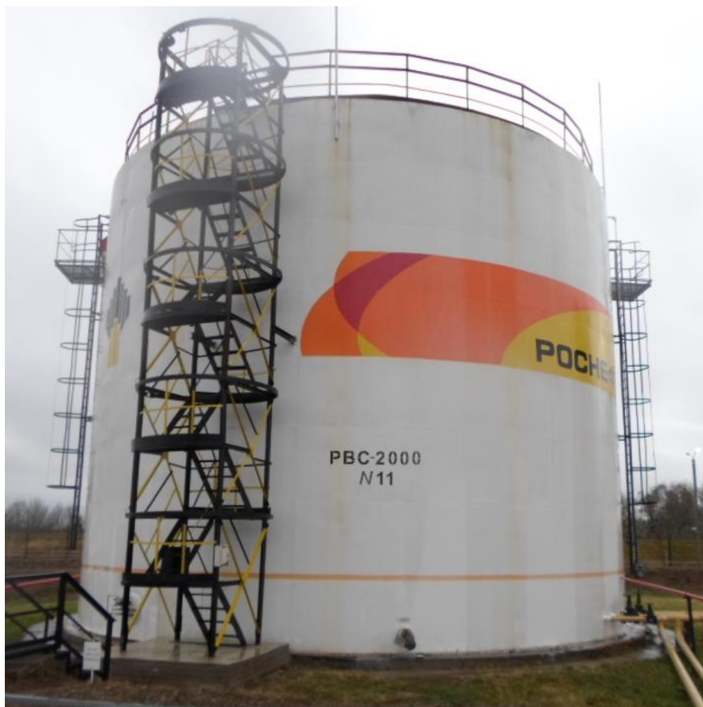
Рисунок 1 - Общий вид резервуара стального вертикального цилиндрического РВС-2000
