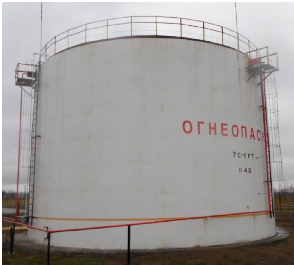
Рисунок 2 - Общий вид резервуара стального вертикального цилиндрического РВС-3000
