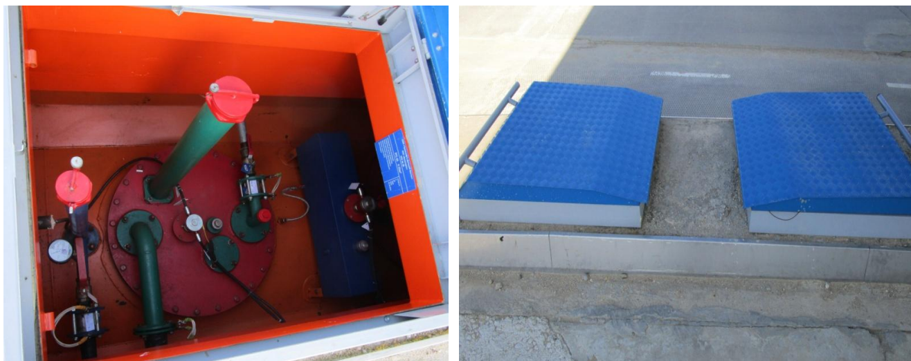
Рисунок 12 - Общий вид видимой части конструкции резервуаров РГСД-50 №№ 26/50-2БХТ, 27/50-2БХТ
