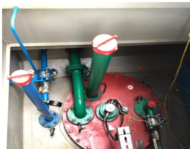
Рисунок 8 - Общий вид видимой части конструкции резервуара РГСД-50 № 4/50-2БХТ
