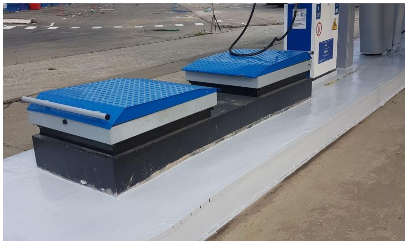
Рисунок 2 - Общий вид видимой части конструкции резервуаров РГСД-25 №№ 1/25-2БХТ, 2/25-2БХТ
