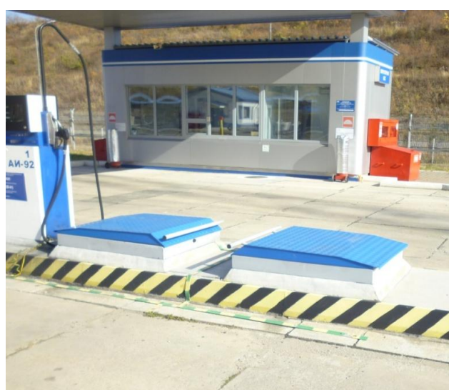
Рисунок 4 - Общий вид видимой части конструкции резервуаров РГСД-50 №№ 5/50-2БХТ, 6/50-2БХТ
