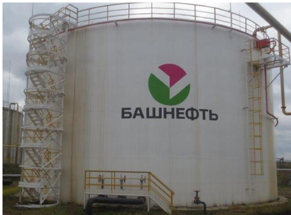
Рисунок 2 - Общий вид резервуара стального вертикального цилиндрического РВС-5000
