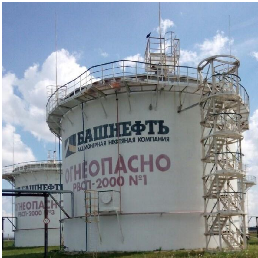
Рисунок 1 - Общий вид резервуара стального вертикального цилиндрического РВС-2000
