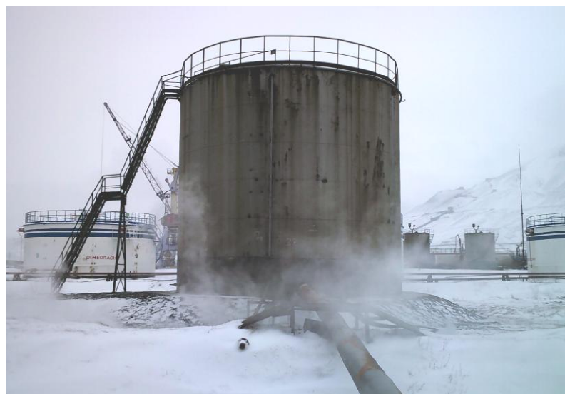
Рисунок 3 - Общий вид резервуара РВС-2000
