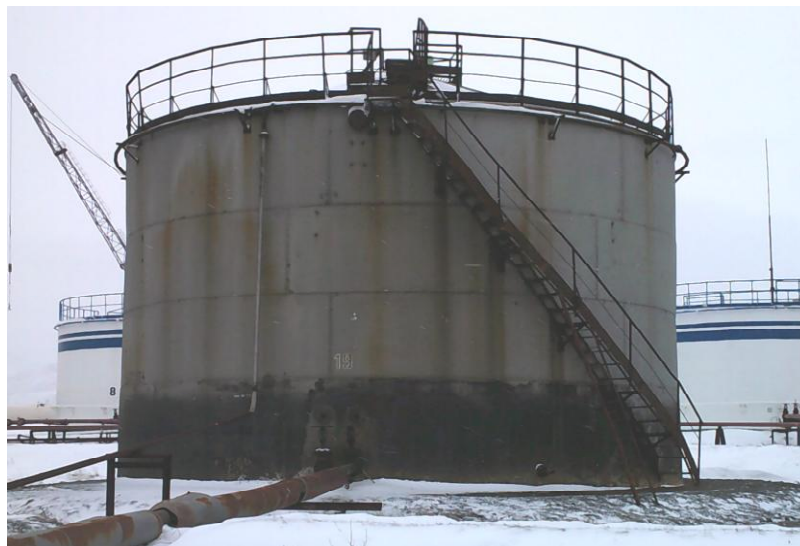
Рисунок 1 - Общий вид резервуара РВС-700
