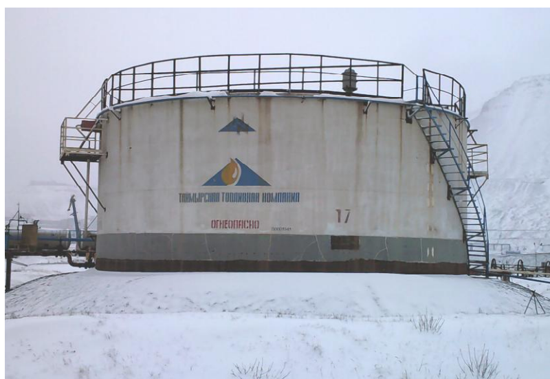
Рисунок 2 - Общий вид резервуара РВС-1000
