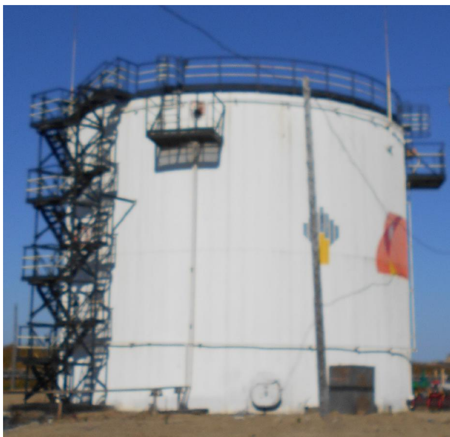
Рисунок 1 - Общий вид резервуара стального вертикального цилиндрического РВС-2000
