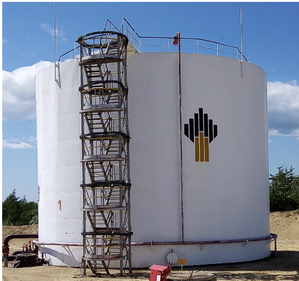
Рисунок 1 - Общий вид резервуара стального вертикального цилиндрического РВС-2000
