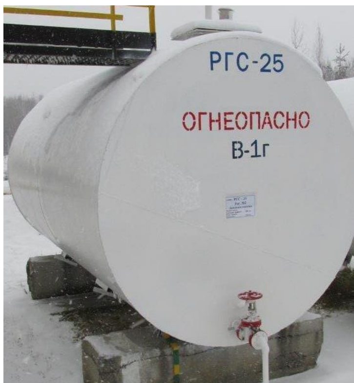
Рисунок 1 - Общий вид резервуаров
