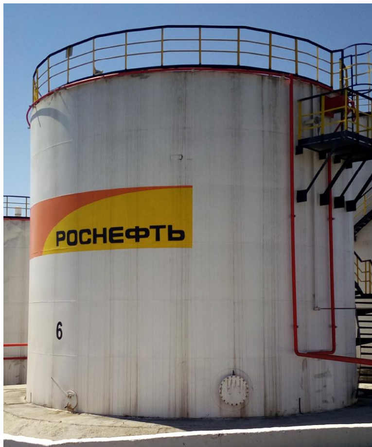
Рисунок 1 - Общий вид резервуара стального вертикального цилиндрического РВС-700
