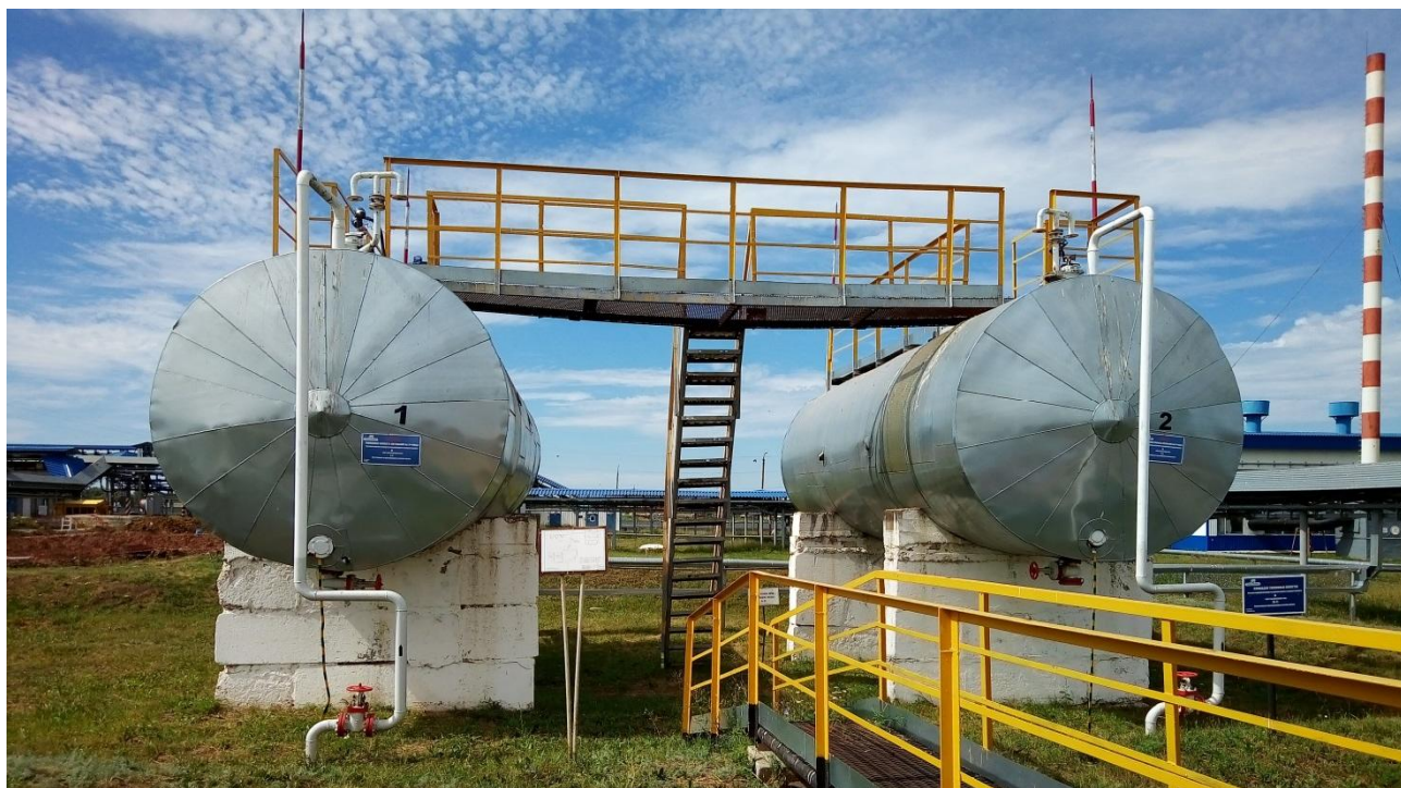
Рисунок 1 - Общий вид резервуаров РГС-50 №№ 1, 2
