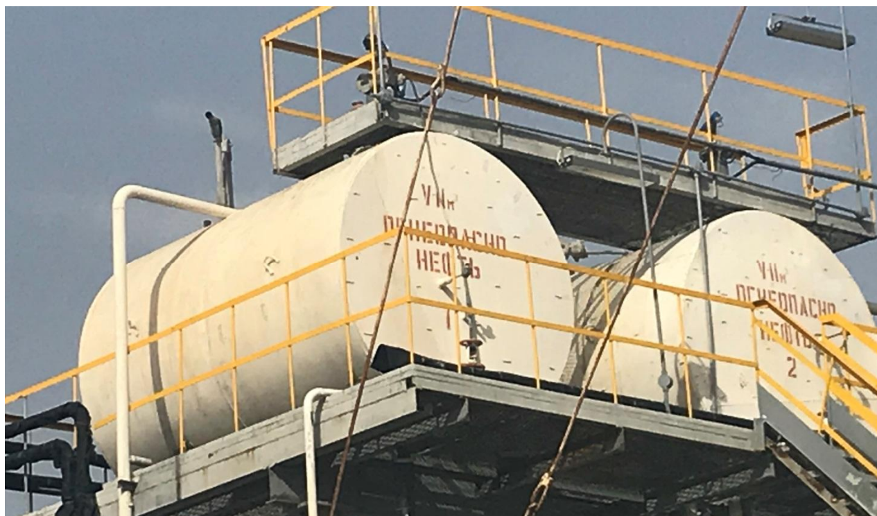
Рисунок 1 - Общий вид резервуаров РГС-10 № 5, 6 (НПС «Екатериновка»)
