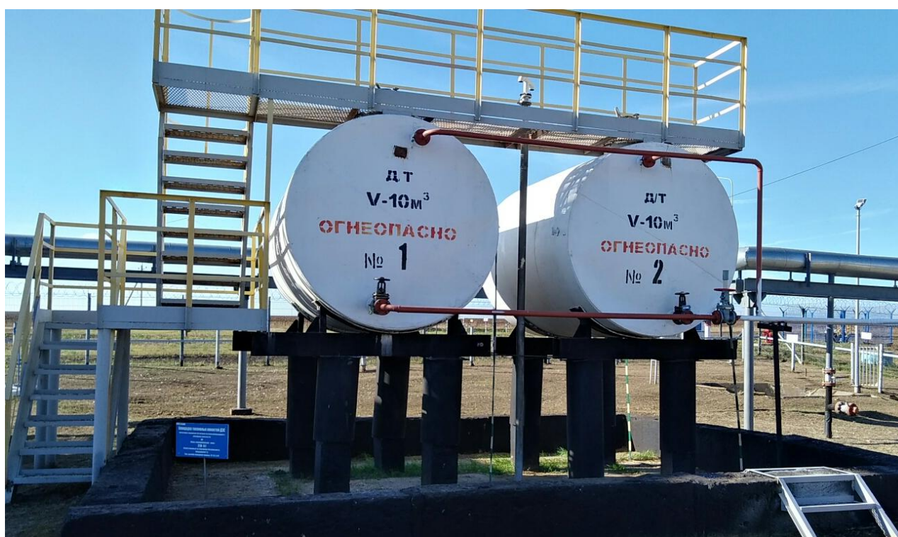
Рисунок 2 - Общий вид резервуара РГС-10 № 1, 2 (ЛПДС «Андеяновская»)
