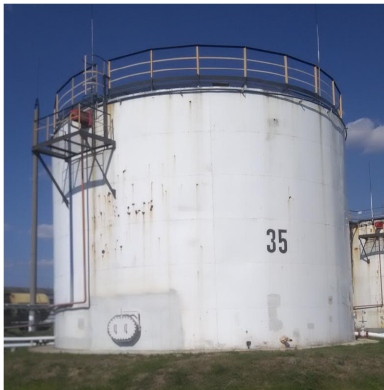
Рисунок 1 - Общий вид резервуара РВСП-1000
