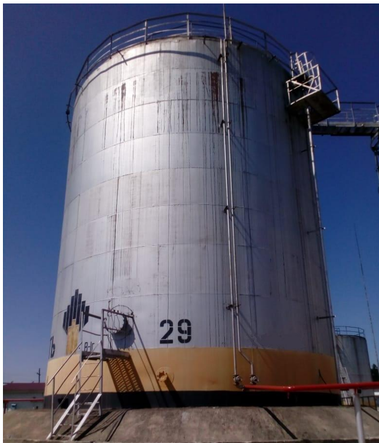
Рисунок 1 - Общий вид резервуара стального вертикального цилиндрического РВС-1000
