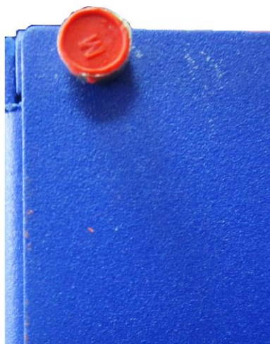
Рисунок 2 – Место пломбировки регистратора от несанкционированного доступа
