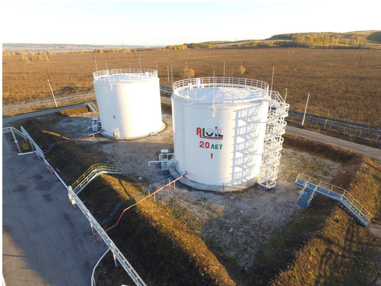
Рисунок 1 - Общий вид резервуаров РВС-2000
