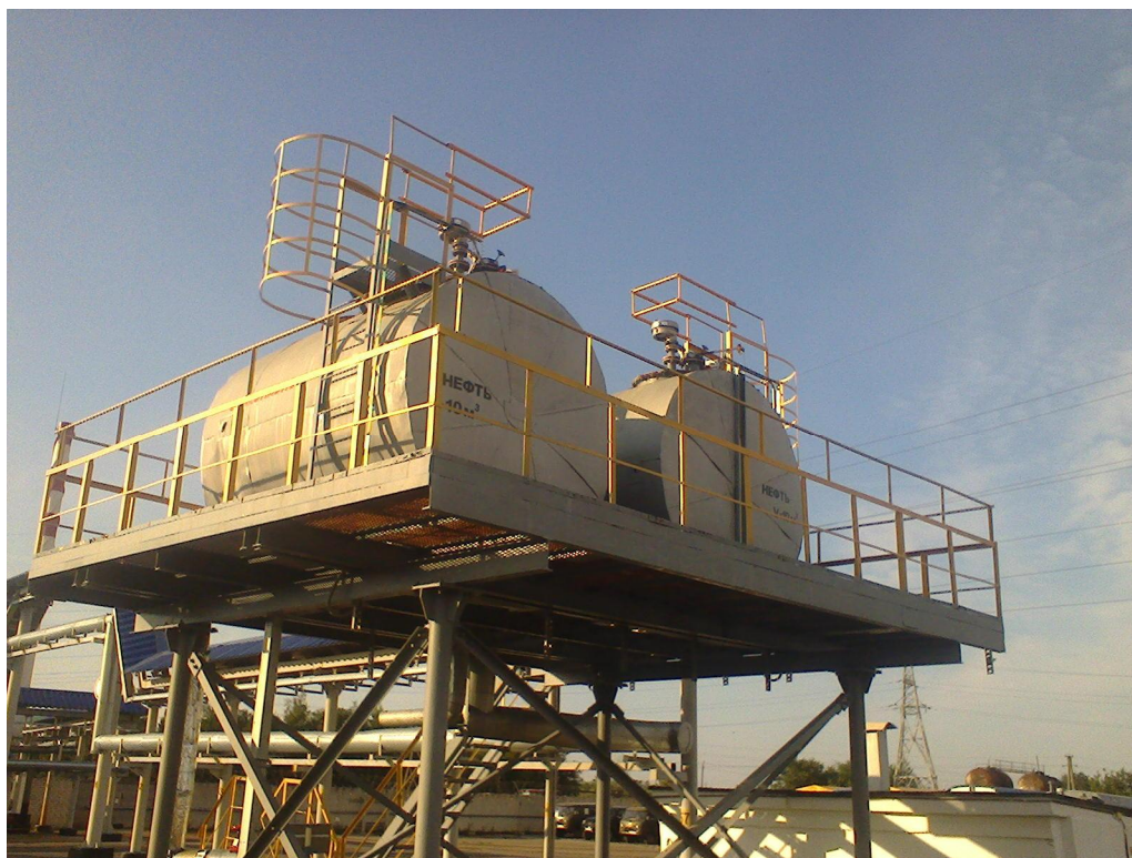
Рисунок 1 - Общий вид резервуара РГС-10
