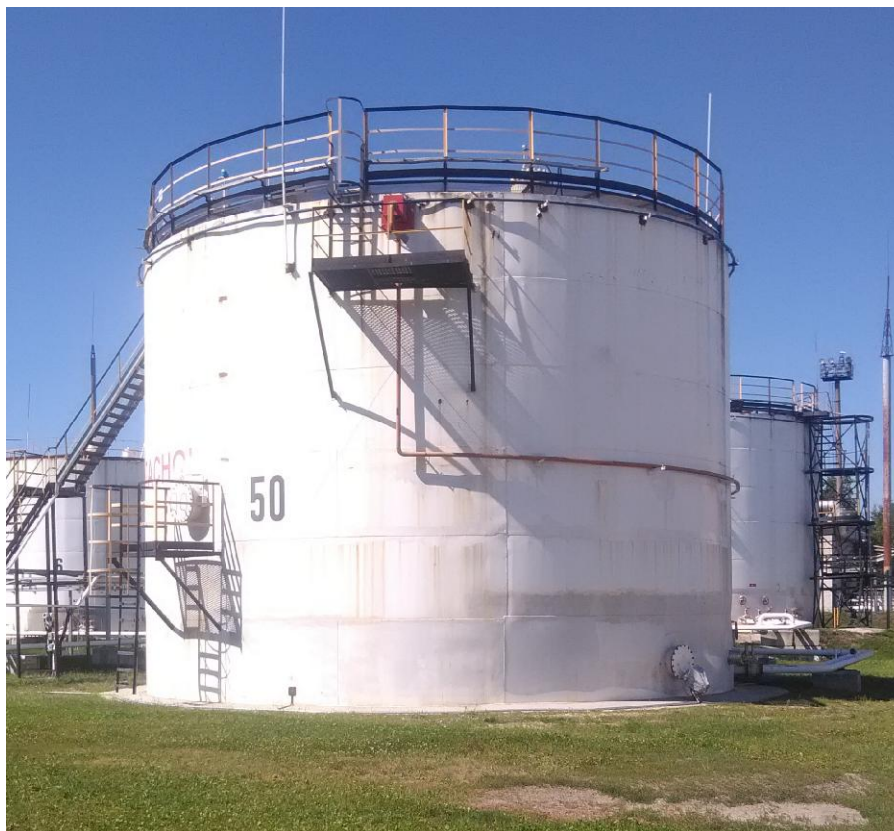
Рисунок 1 - Общий вид резервуара РВСП-1000
