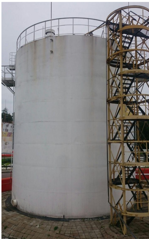
Рисунок 1 - Общий вид резервуара стального вертикального цилиндрического РВС-1000
