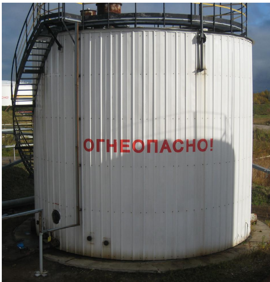
Рисунок 1 - Общий вид резервуара стального вертикального цилиндрического РВС-400
