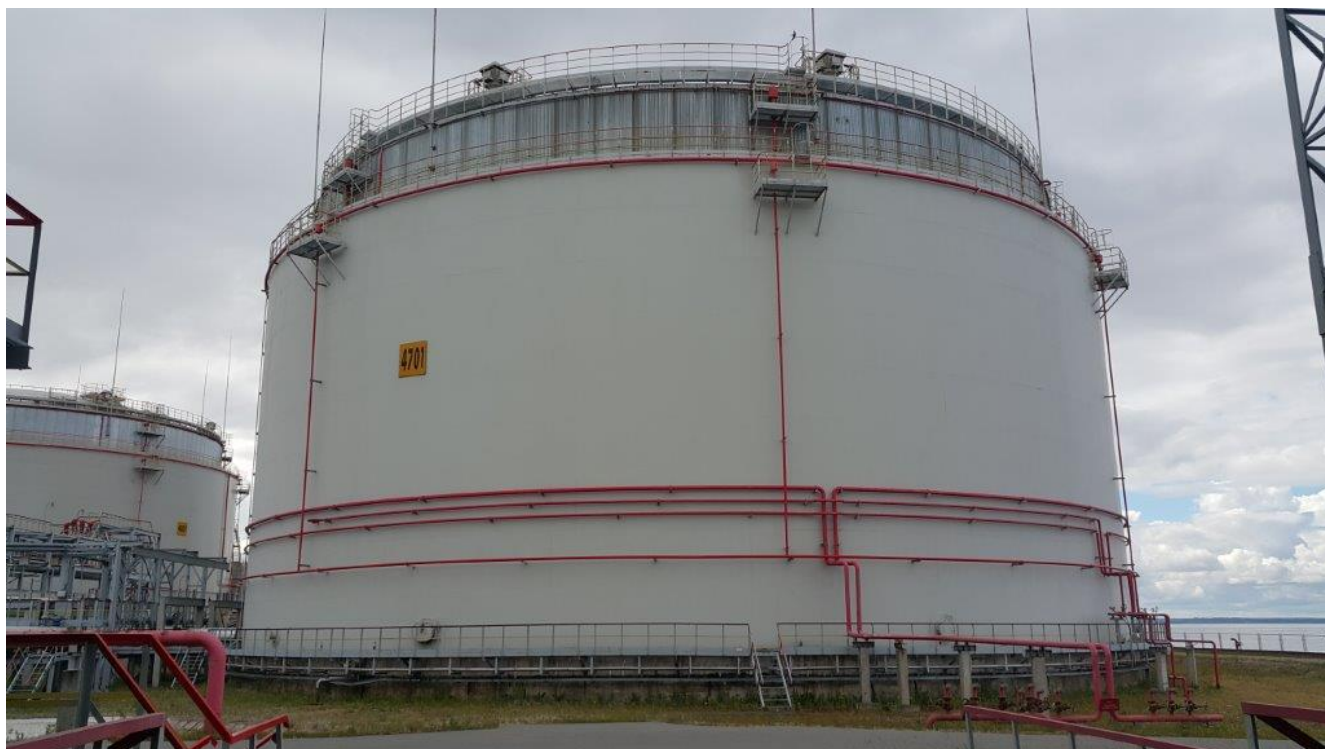
Рисунок 1 - Общий вид резервуара РВСтзс-40000
