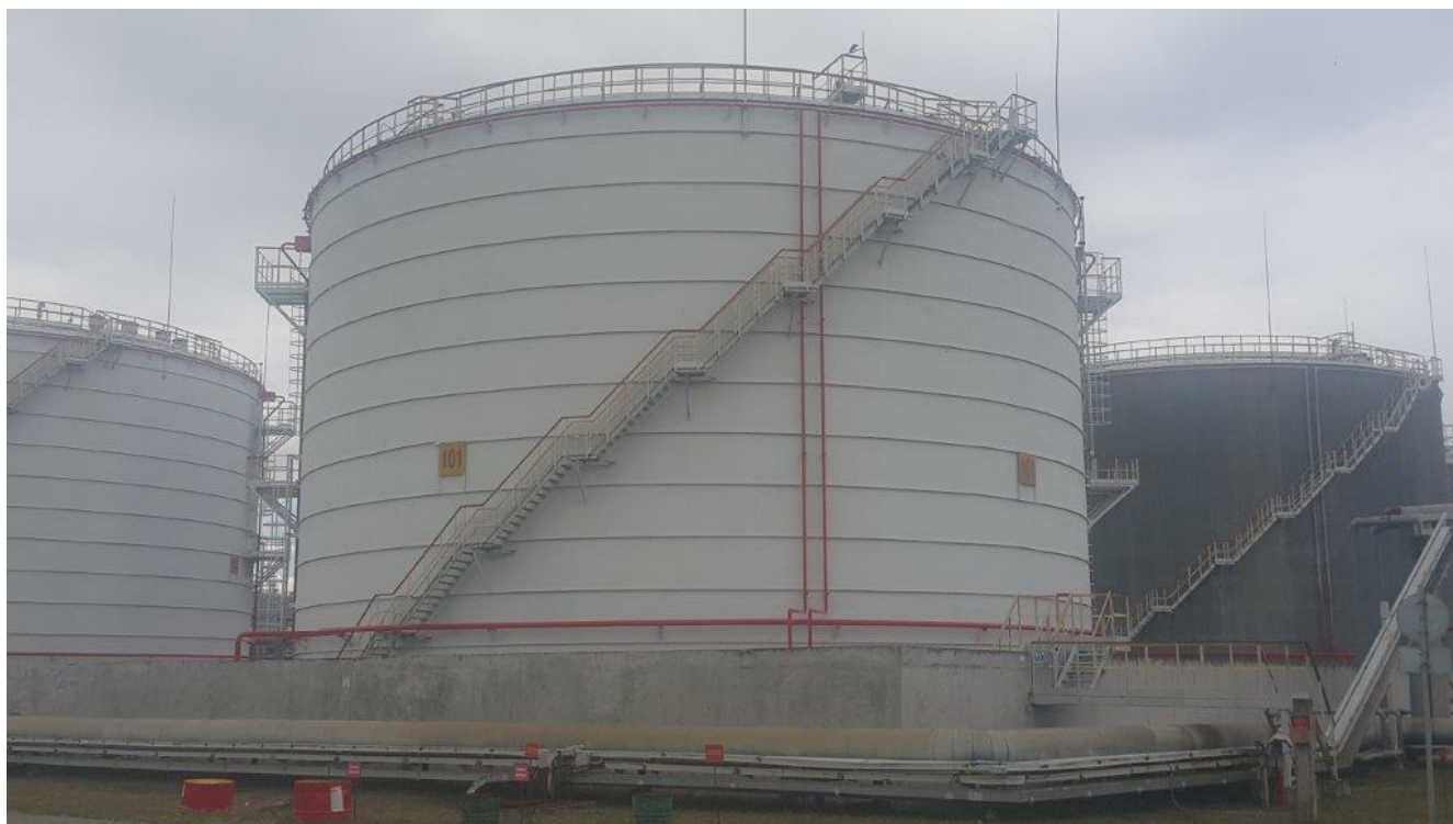
Рисунок 1 - Общий вид резервуара РВС-10000
