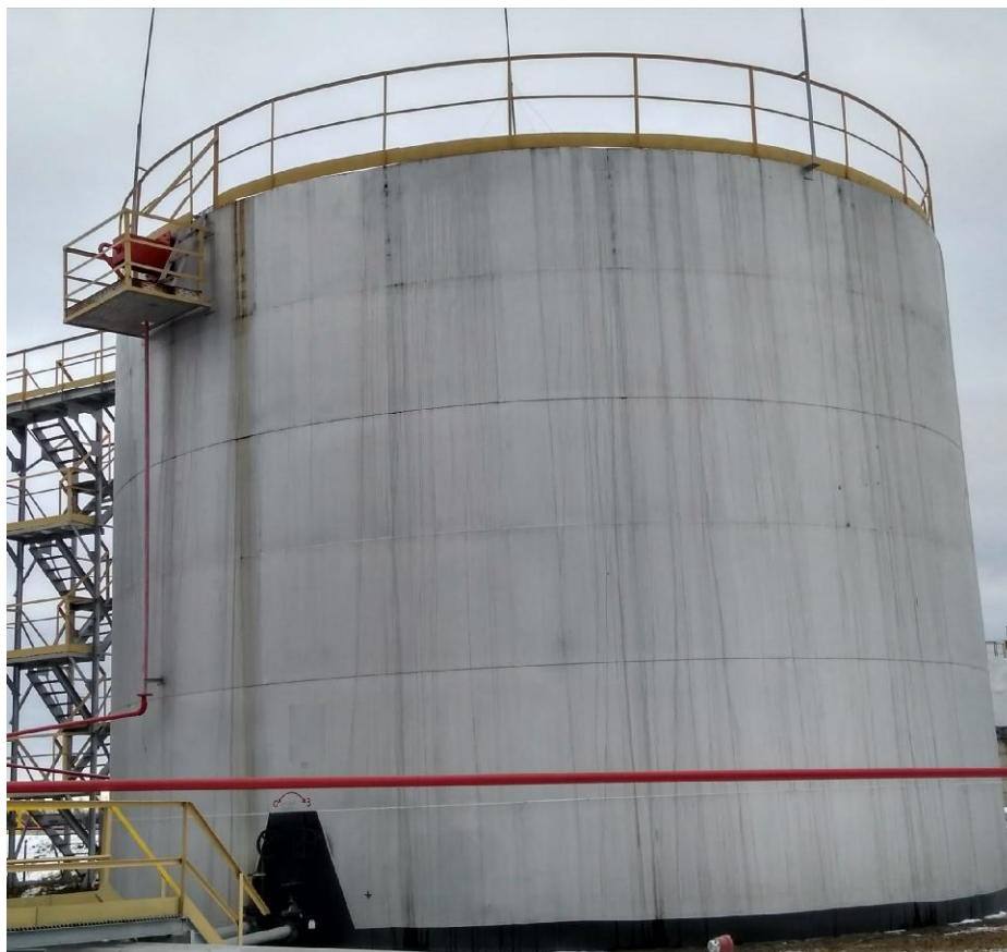
Рисунок 1 - Общий вид резервуара стального вертикального цилиндрического РВС-1000
