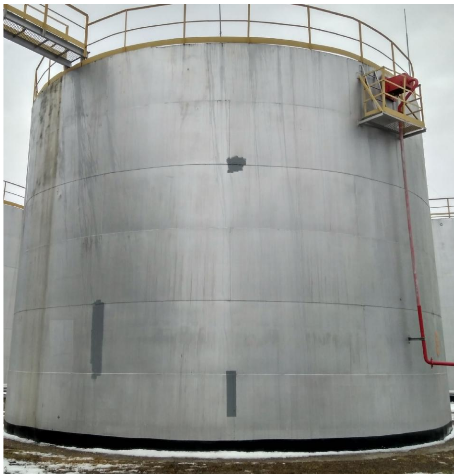
Рисунок 2 - Общий вид резервуара стального вертикального цилиндрического РВС-1000
