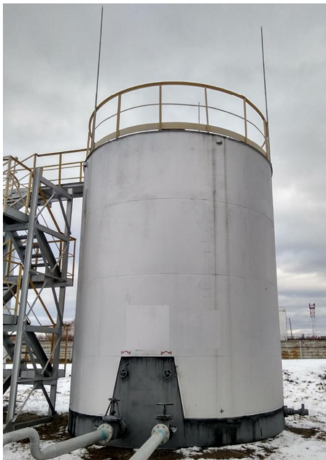
Рисунок 1 - Общий вид резервуара стального вертикального цилиндрического РВС-100
