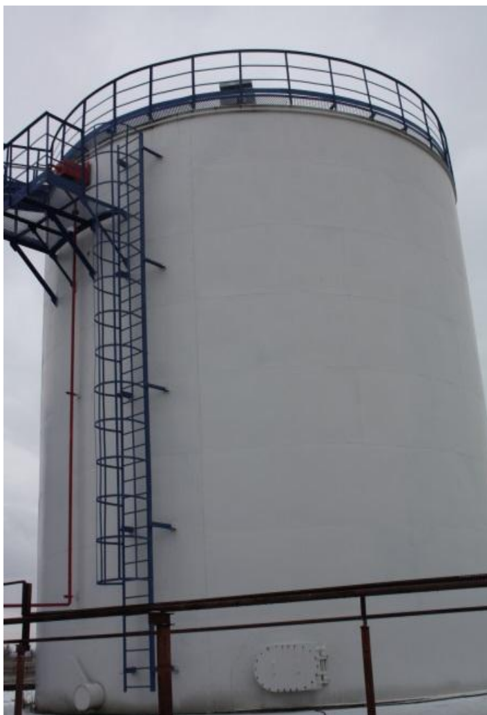
Рисунок 1 - Общий вид резервуара стального вертикального цилиндрического РВС-1000
