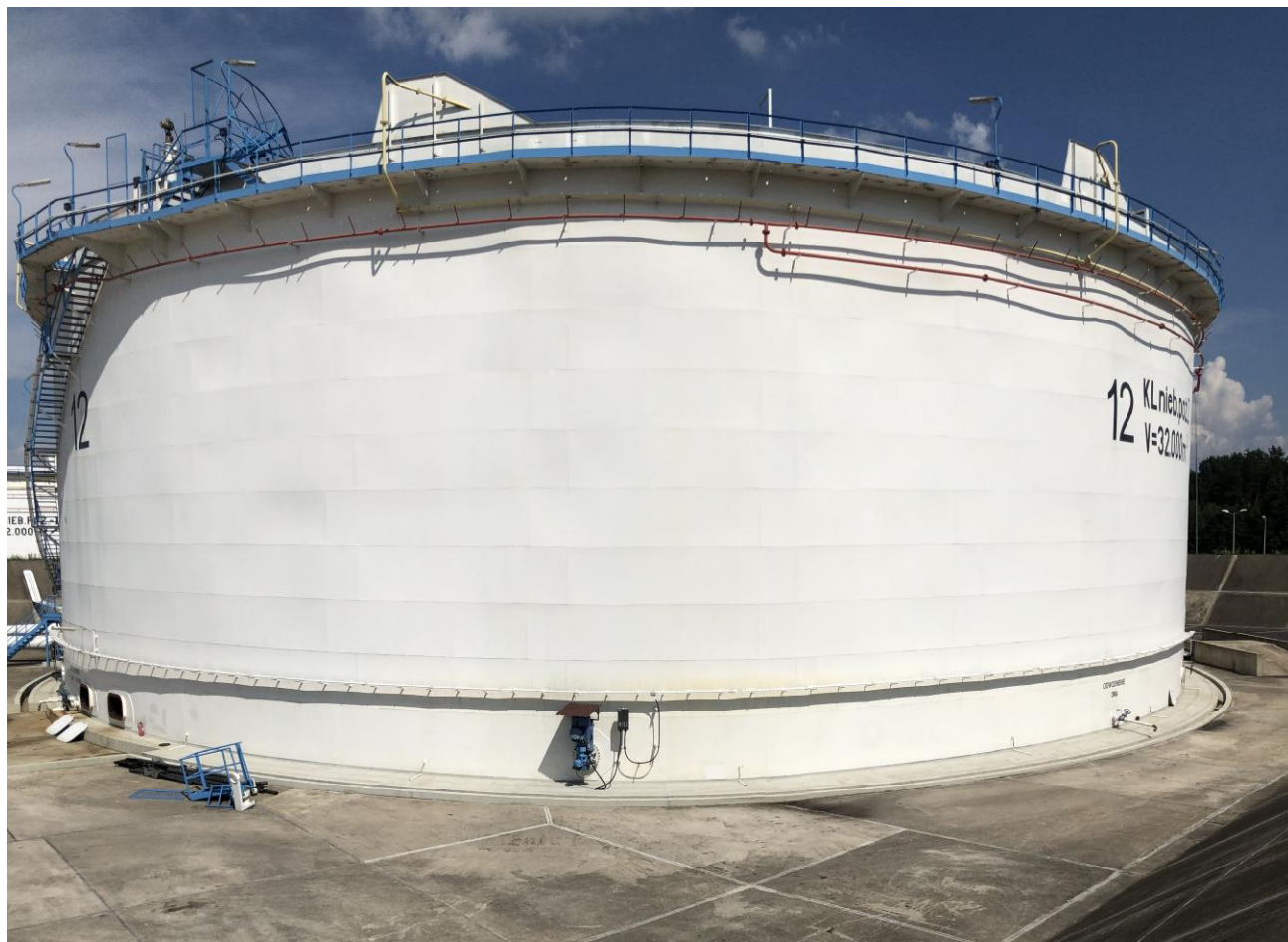
Рисунок 1 - Общий вид резервуара РВСПК-32000
