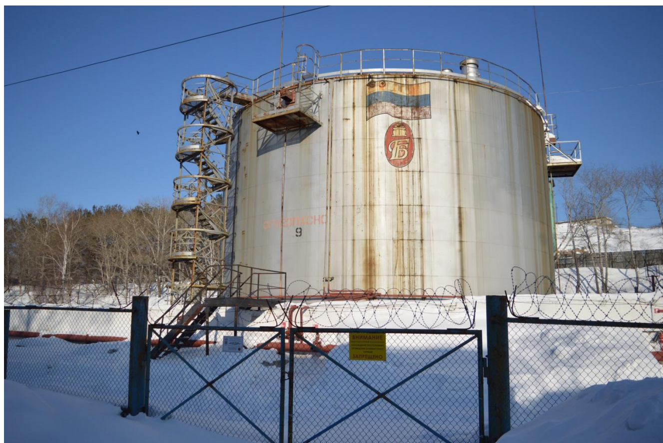
Рисунок 1 - Общий вид резервуара РВС-3000
