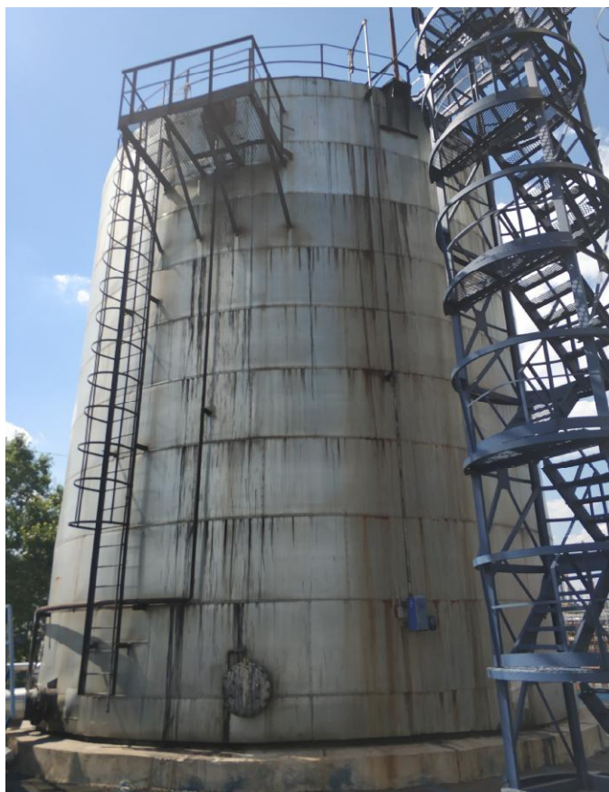
Рисунок 1 - Общий вид резервуара РВС-1000
