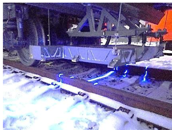
Рисунок 2 - Общий вид модуля контроля геометрии пути и рельсов
