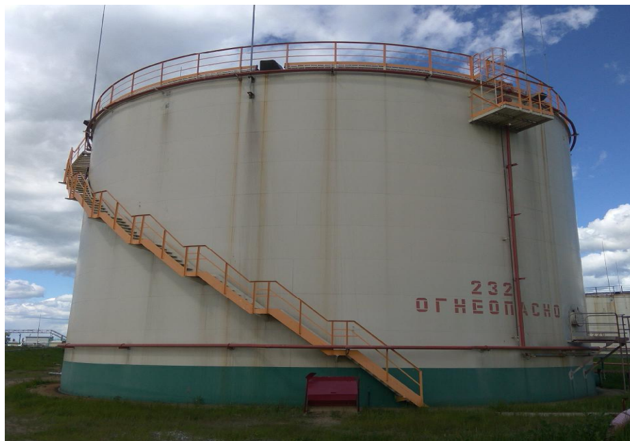
Рисунок 1 - Общий вид резервуара РВСП-5000
