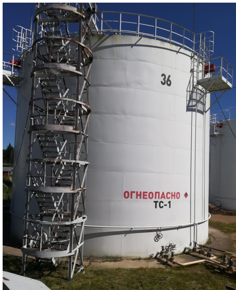
Рисунок 1 – Общий вид резервуара РВС-2000
