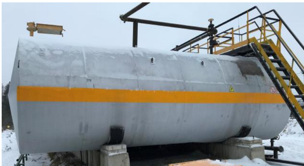
Рисунок 1 - Общий вид резервуара стального горизонтального цилиндрического РГС-50
