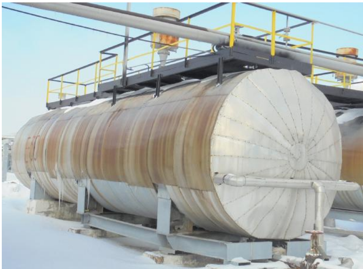
Рисунок 1 – Общий вид резервуара стального горизонтального цилиндрического РГС-100
