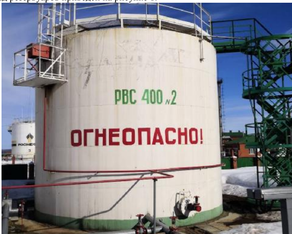
Рисунок 1 - Общий вид резервуара РВС-400
