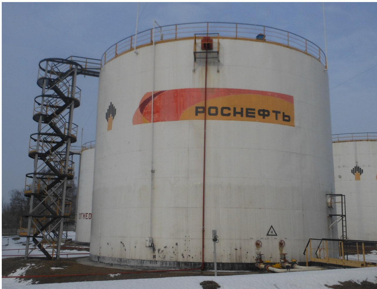
Рисунок 1 – Общий вид резервуара стального вертикального цилиндрического РВСП-2000
