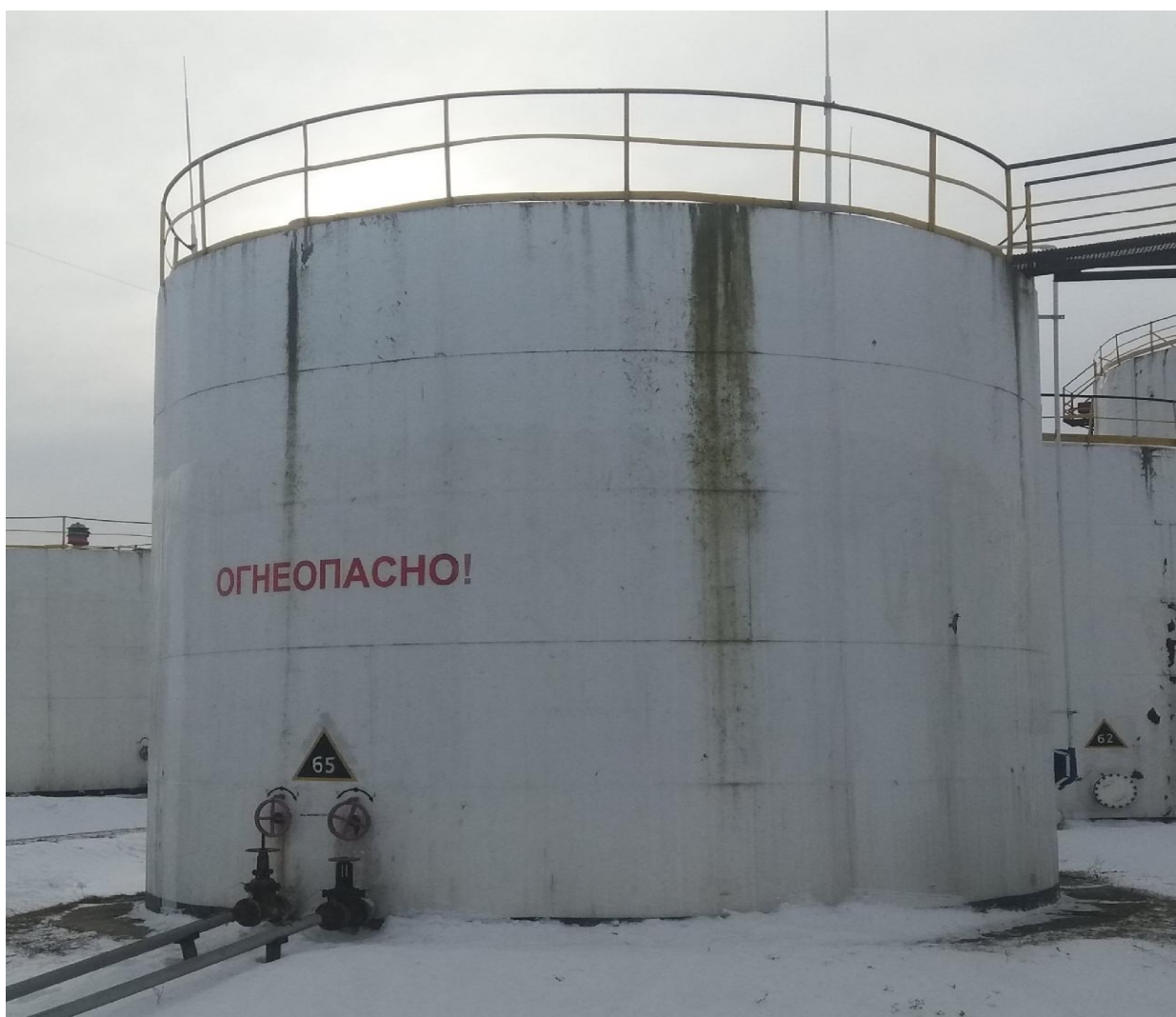
Рисунок 2 – Общий вид резервуара стального вертикального цилиндрического РВС-400
