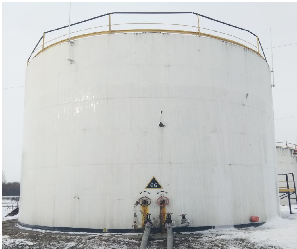
Рисунок 1 – Общий вид резервуара стального вертикального цилиндрического РВСП-1000
