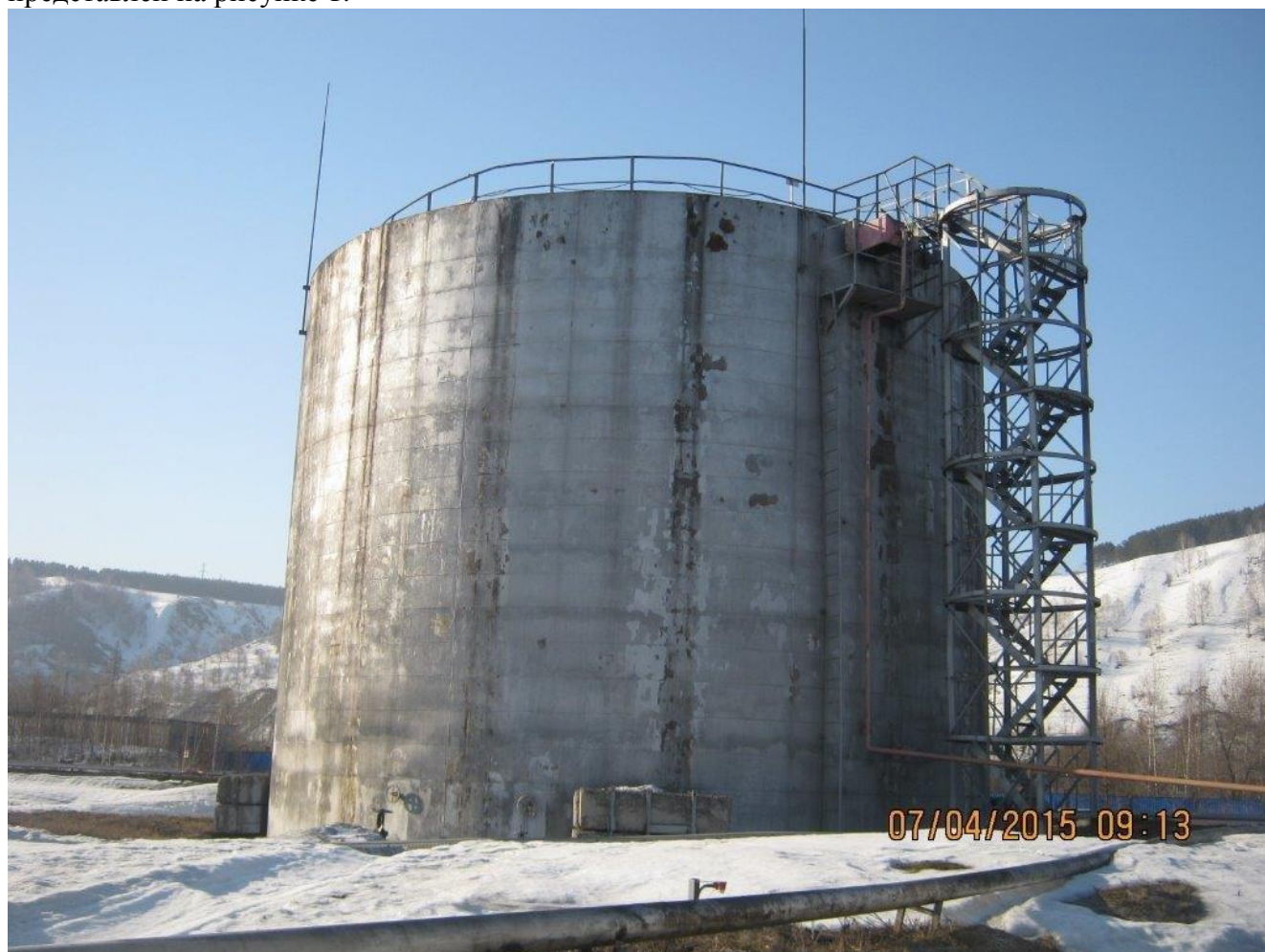
Рисунок 1 – Общий вид резервуара вертикального стального цилиндрического РВС-2000
