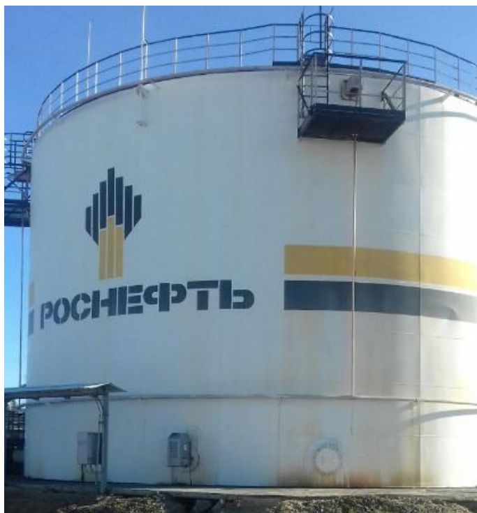
Рисунок 1 - Общий вид резервуара
