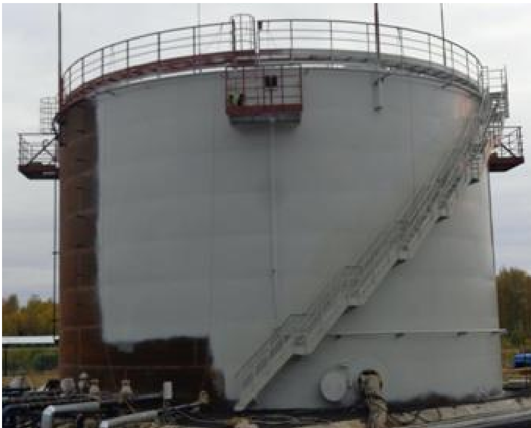
Рисунок 1 – Общий вид резервуара
