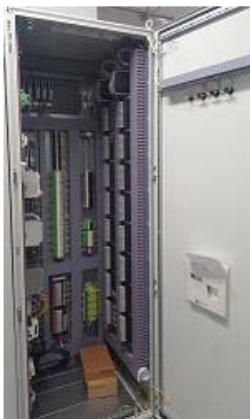
Рисунок 1 - Общий вид контроллера в приборном шкафу (с открытой дверцей)
