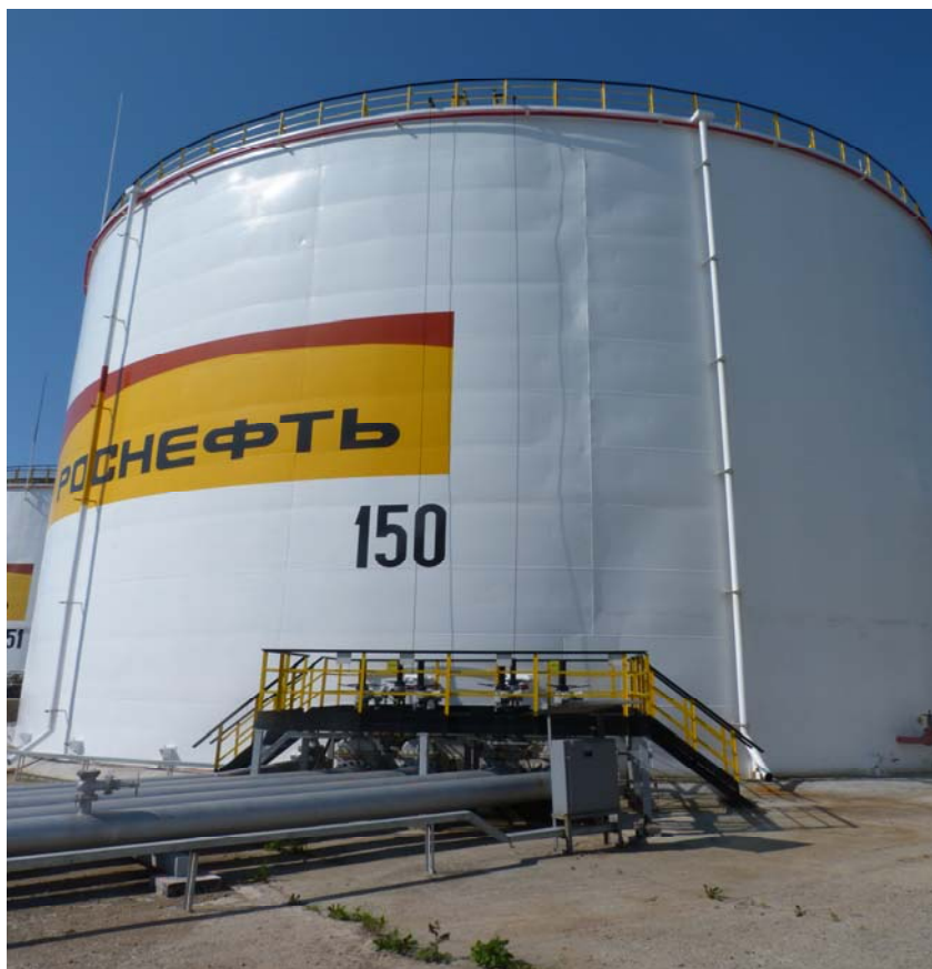
Рисунок 1 - Общий вид резервуара вертикального стального цилиндрического РВС-10000
