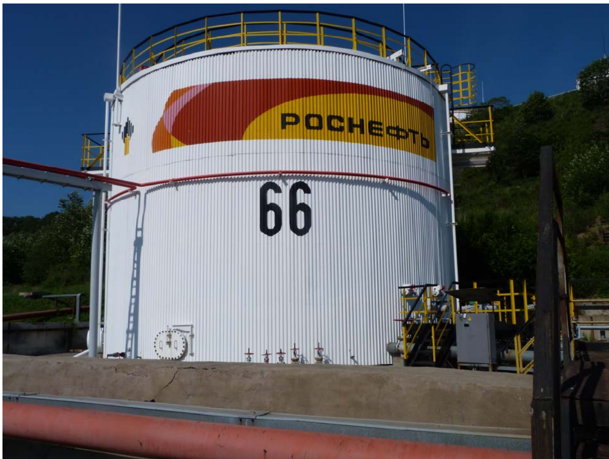
Рисунок 1 - Общий вид резервуара вертикального стального цилиндрического РВС-1000
