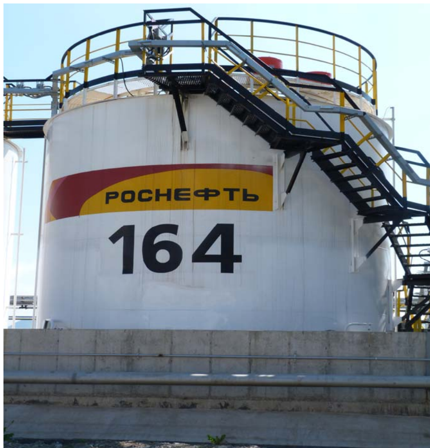
Рисунок 1 - Общий вид резервуара вертикального стального цилиндрического РВС-200
