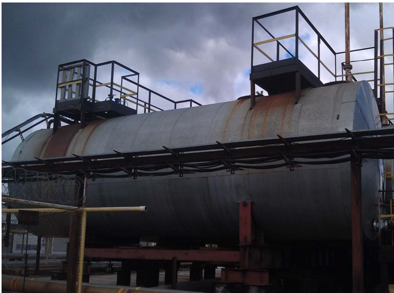
Рисунок 1 - Общий вид резервуара стального горизонтального цилиндрического РГС-75
