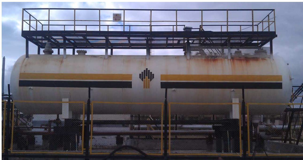
Рисунок 2 - Общий вид резервуара стального горизонтального цилиндрического РГС-100
