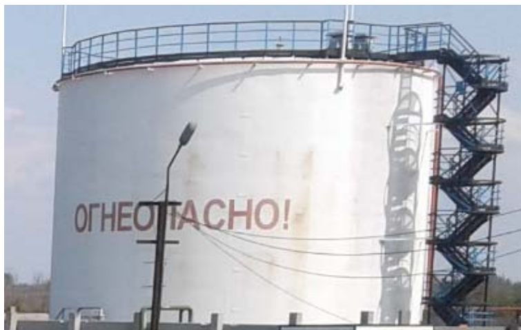
Рисунок 1 - Общий вид резервуара
