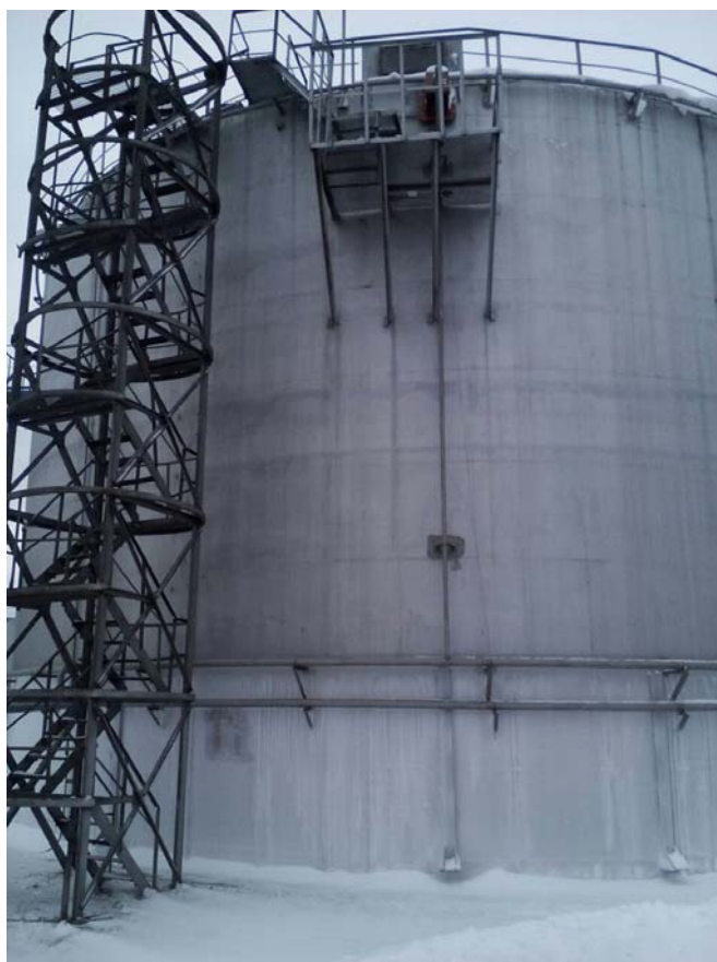
Рисунок 1 - Общий вид резервуара вертикального стального цилиндрического РВС-3000
