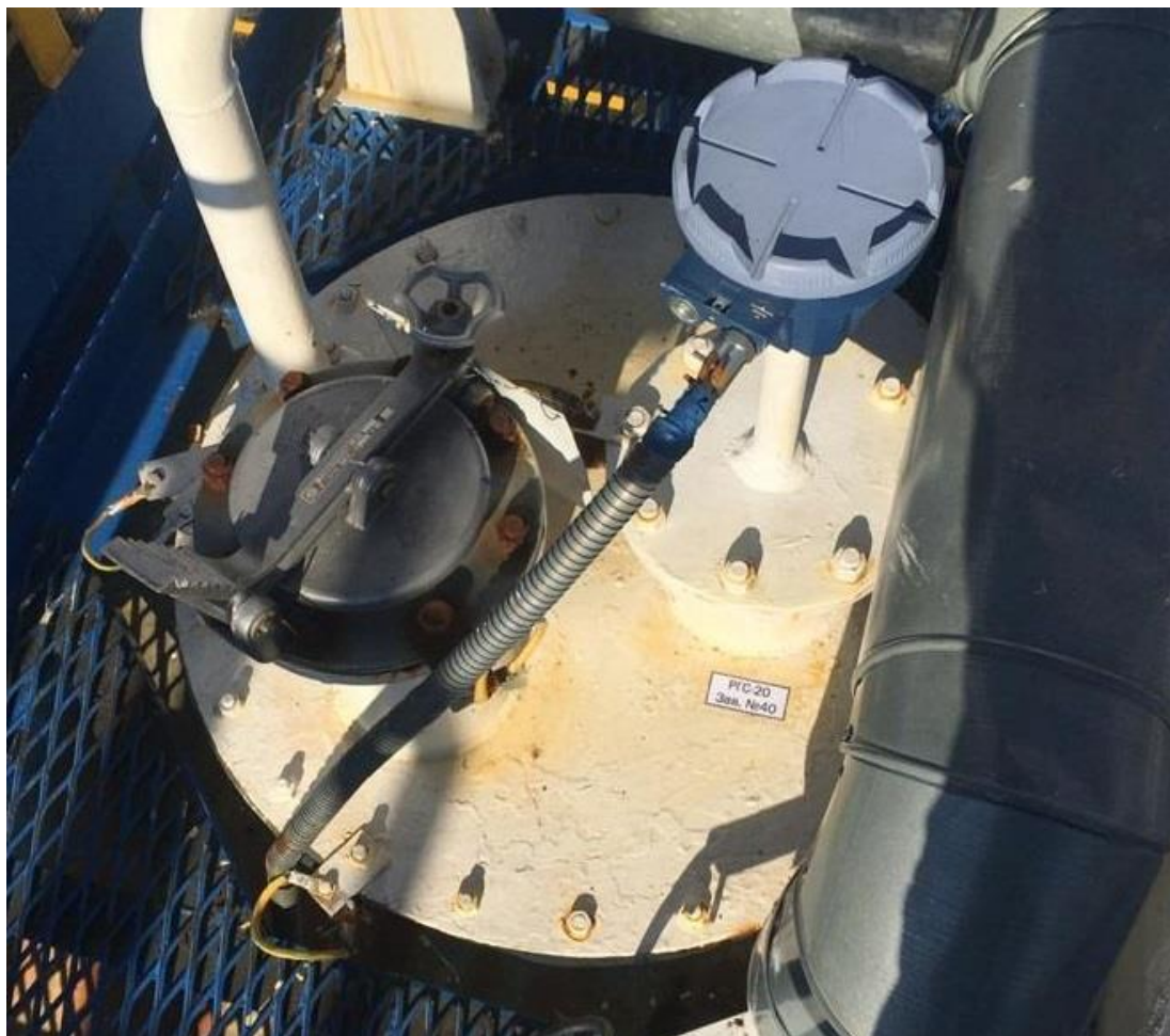
Рисунок 3 – Общий вид резервуаров РГС-20, зав.№40
