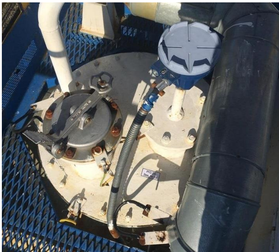
Рисунок 2 – Общий вид резервуаров РГС-20 зав.№39
