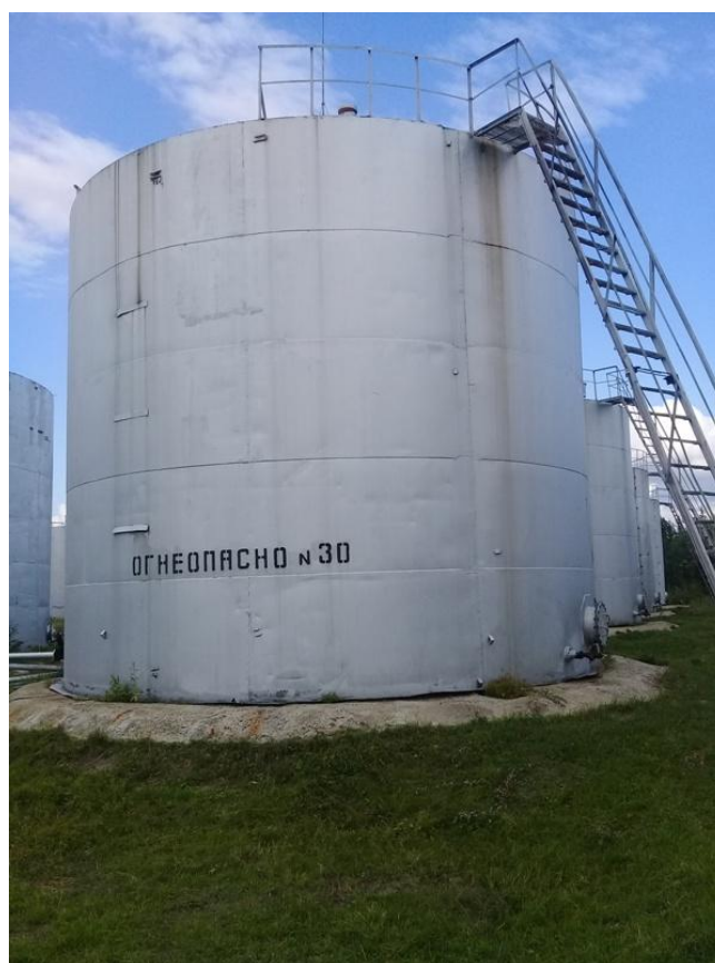
Рисунок 2 - Общий вид резервуара РВС-400
