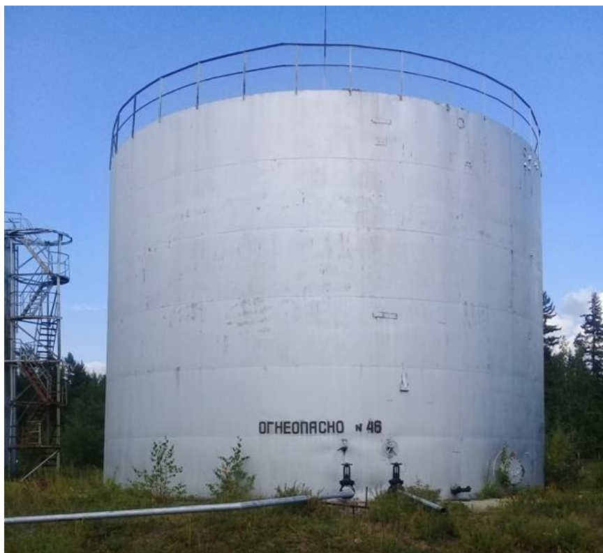
Рисунок 4 - Общий вид резервуара РВС-1000
