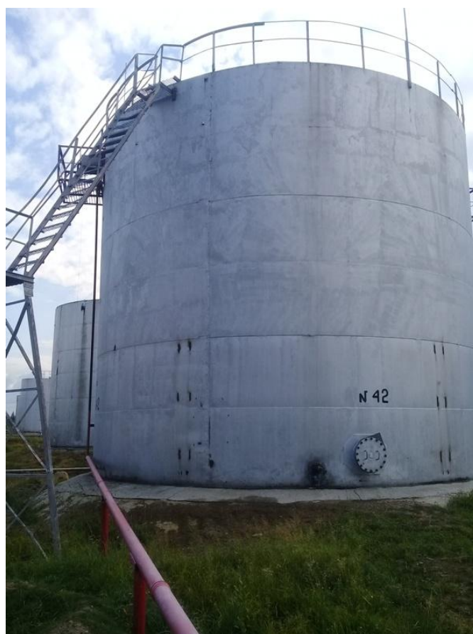
Рисунок 3 - Общий вид резервуара РВС-700
