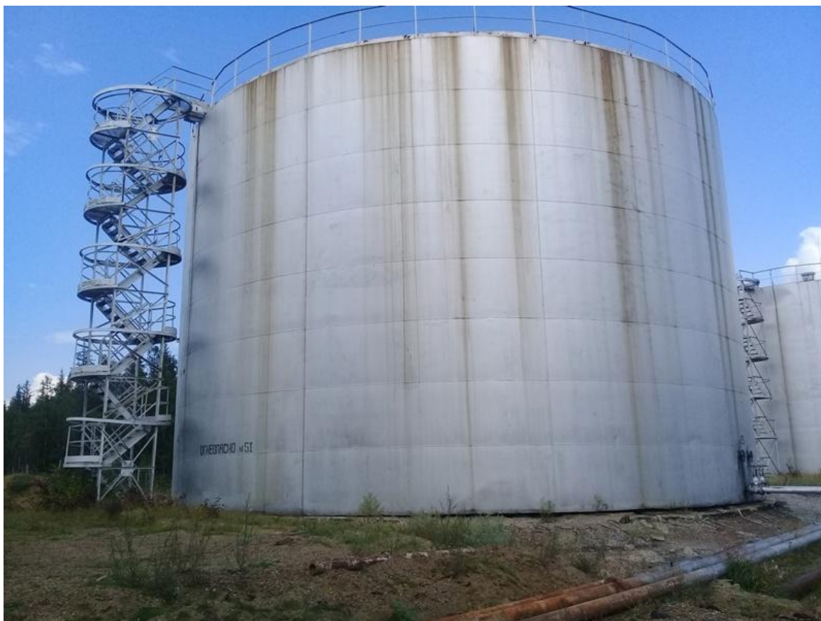
Рисунок 6 - Общий вид резервуара РВС-3000
