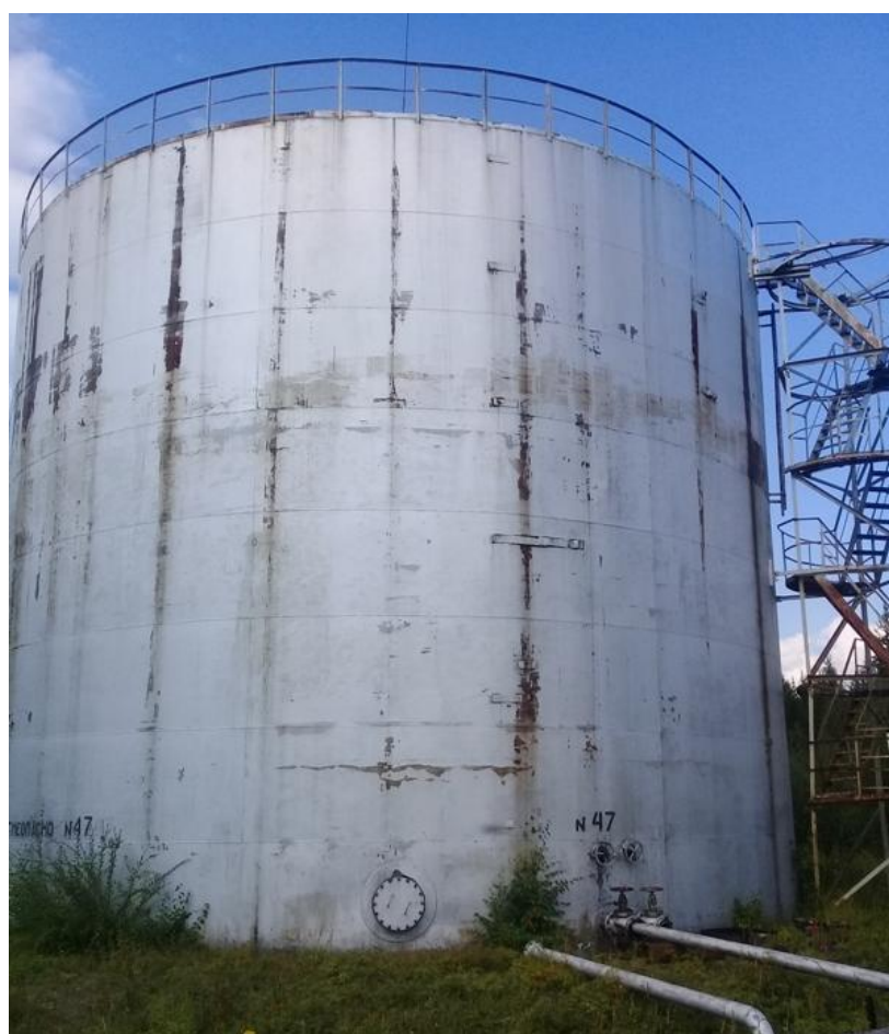
Рисунок 5 - Общий вид резервуара РВС-2000
