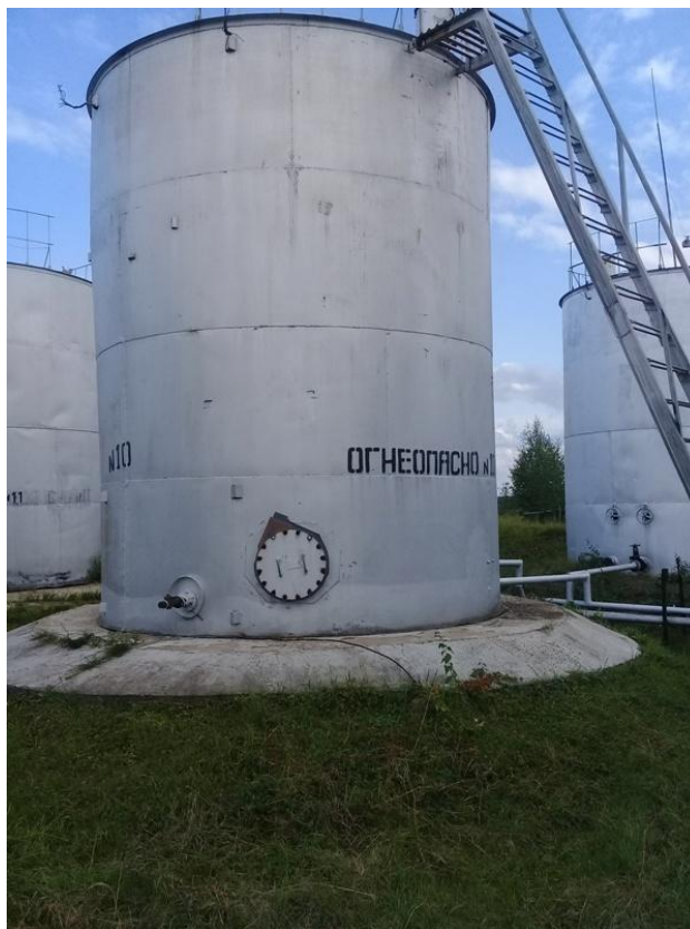
Рисунок 1 - Общий вид резервуара РВС-100
