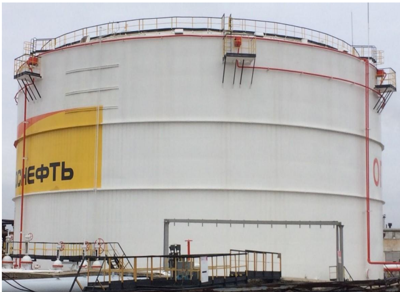
Рисунок 1 - Общий вид резервуара стального вертикального цилиндрического РВС-20000
