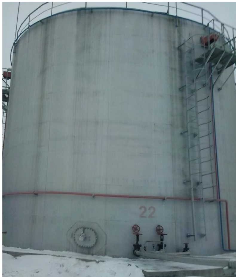
Рисунок 1 - Общий вид резервуара вертикального стального цилиндрического РВС-2000
