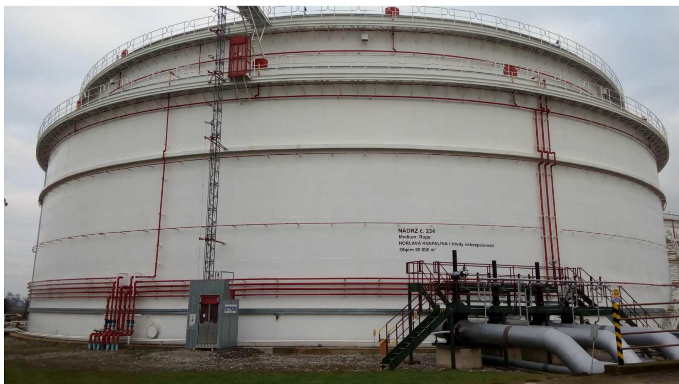
Рисунок 1 - Общий вид резервуара РВСПК-50000
